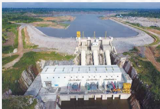
9. Det kinesiskfinansierede og -byggede Soubre-vandkraftværk nær byen Soubre i Elfenbenskysten påbegynder produktion af elektricitet den 1. juli, 2017.
