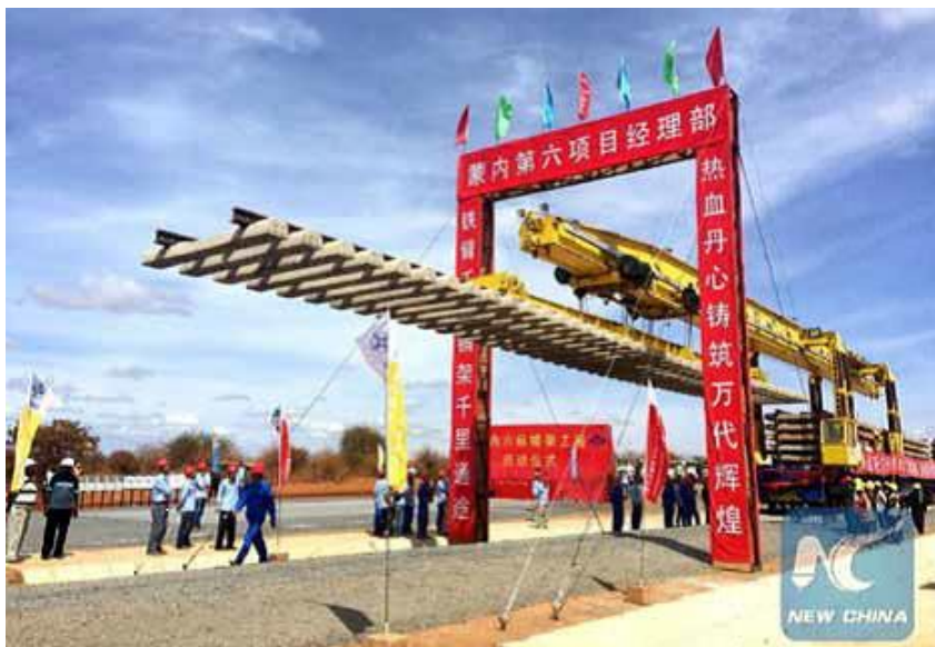
Kinas Vej- og Broselskab demonstrerer en ny teknologi for at lægge jernbanespor, i projektet med standard sporafstand i Kenya, oktober, 2015.
